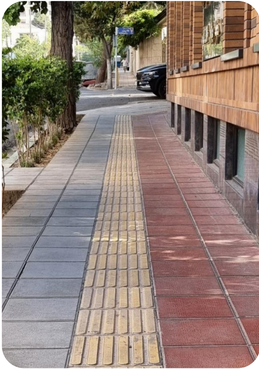
• کف سازی مناسب در پیاده بارنگ‌های متنوع و همچنین مسیر عبور نابینایان
