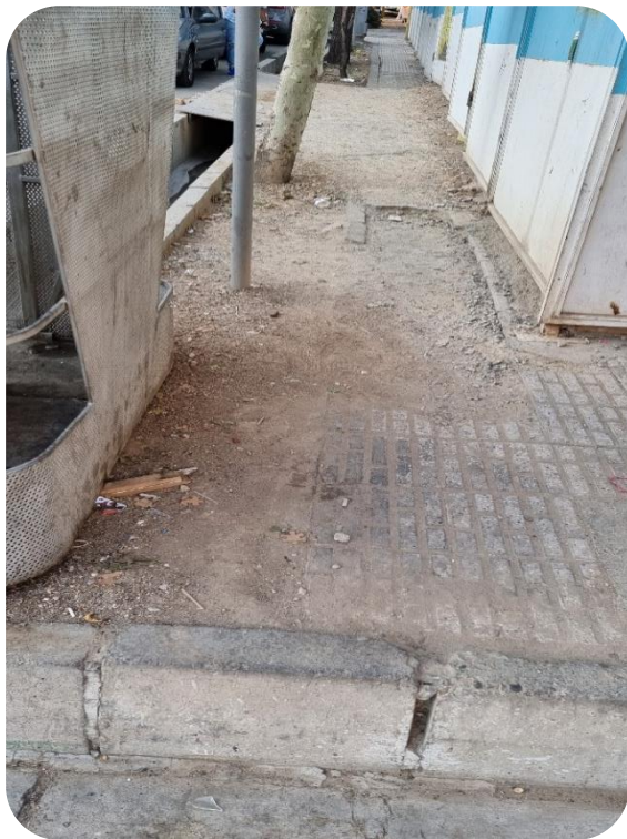
• سطح پیاده‌رو در مجاورت ساختمان در حال احداث نامناسب برای عبور و وجود سنگ لبه پیاده‌رو حرکت سالمندان و معلولان را دشوار می‌کند
